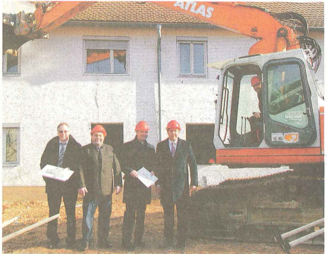
Gaben den offiziellen Startschuss für die Abbrucharbeiten: (von links) Geschäftsleitender Beamter Hans Schmid, Unternehmer Werner Biersack, Volksbankdirektor Josef Wenninger, Investor Richard Balk und - im Bagger - Bürgermeister Josef Pellkofer.
