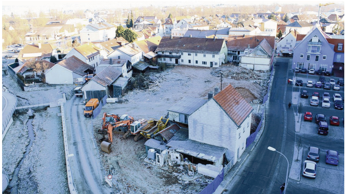
Ein Blick von oben: Schon ein großer Teil der alten Häuser musste dem Bagger weichen.
